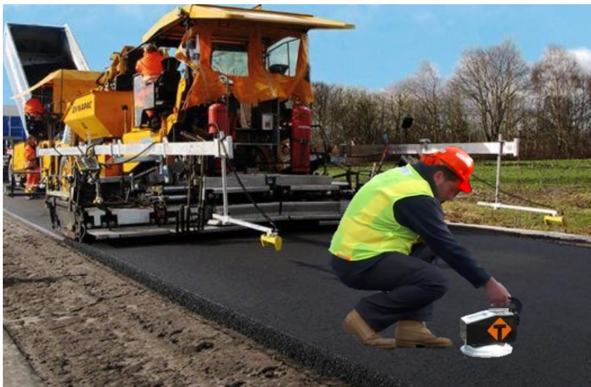
Kvalitetskontroll under legging av ny asfalt parallelt med valsing
