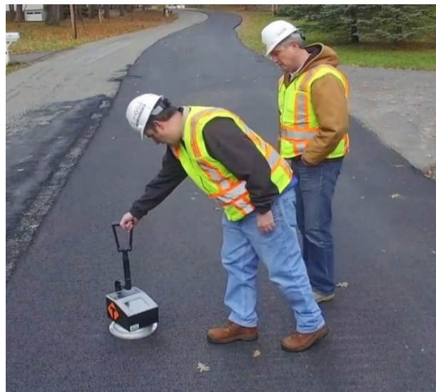
Kvalitetskontroll på ferdig nylagt asfalt
